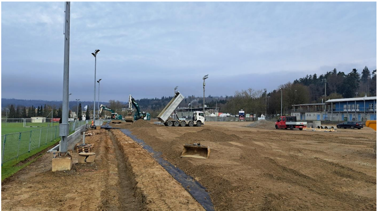
Baustelle Kunstrasen Esp Fislisbach
