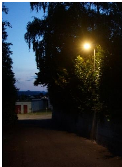
Neue LED-Leuchte auf 10 % gedimmt
