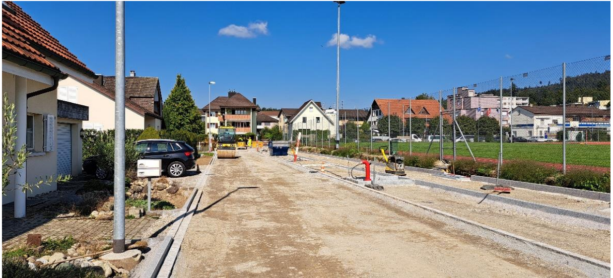
Feldstrasse – Strassensanierung, Zustand vor Belageinbau
