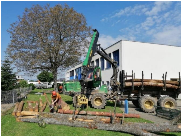
Bauarbeiten durch das Bauamt, den Forstbetrieb Wiss AG und durch den Hauswart
