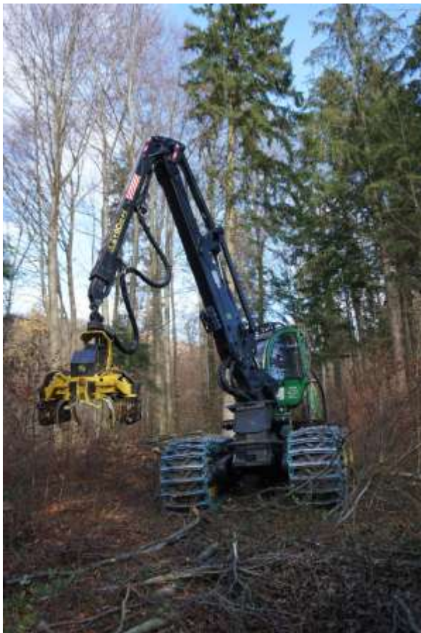
Holzhauereiarbeiten im Fislisbacher Wald
