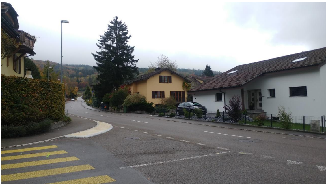
Bauliche Anpassung beim Knoten Moosäcker-/Dorfstrasse
