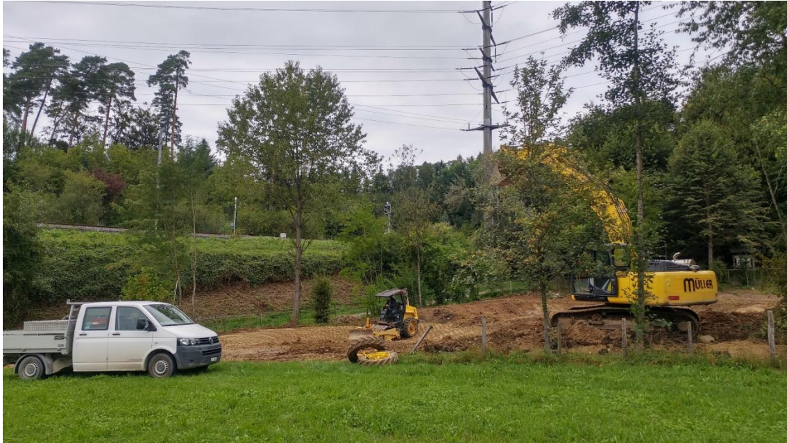
Der kleinere und flachere Naturweiher wird verdichtet und mit Regenwasser befüllt.
