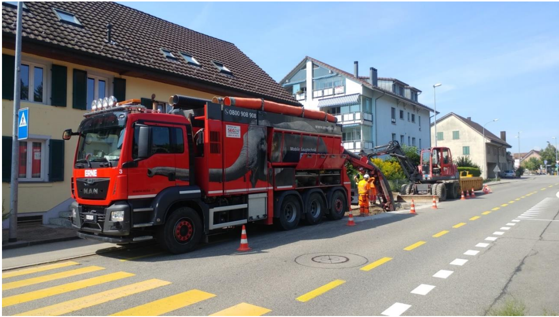
Der Aushub erfolgte mittels Saugbagger
