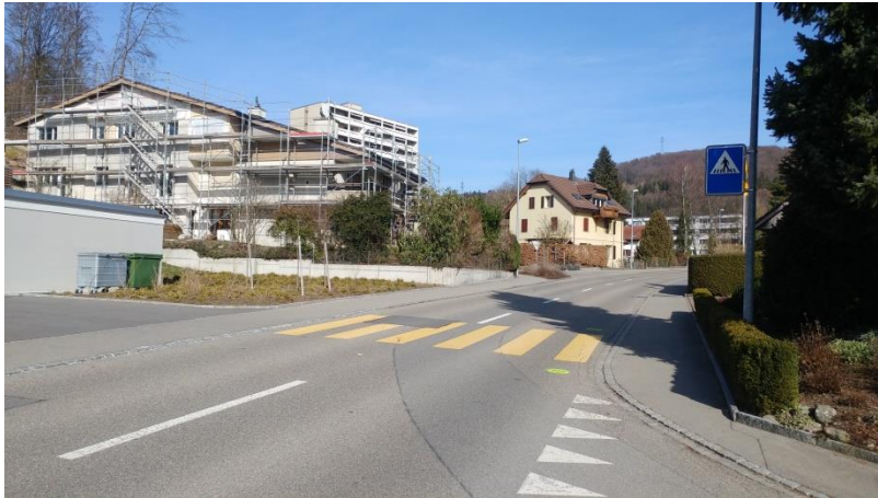
Fussgängerstreifen Matrütistrasse – örtliche Einengung auf 5 m; Sicherung des Wartebereichs mit zwei "Biene-Maja"-Pfosten
