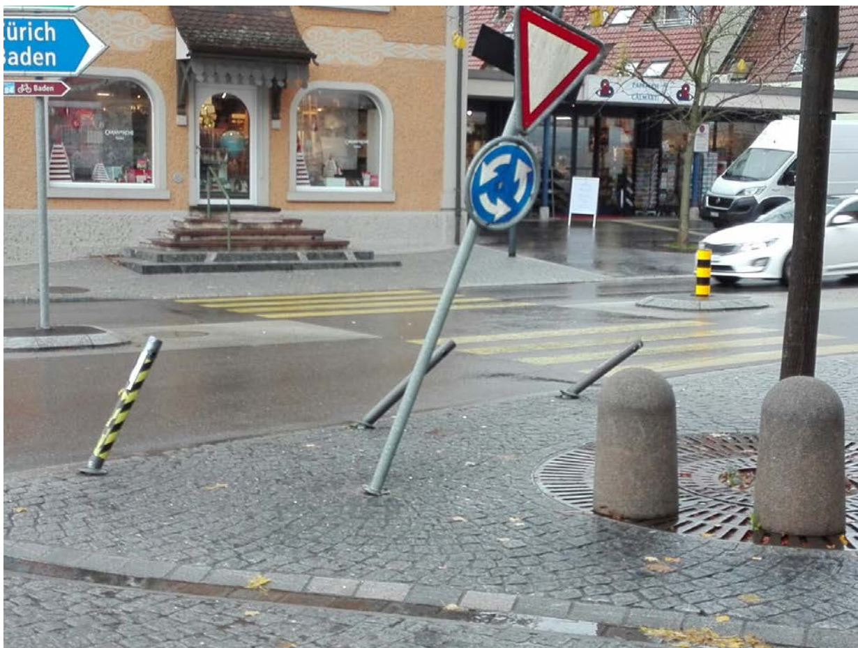
Sachschaden beim "Linden"-Kreisel in Fislisbach
