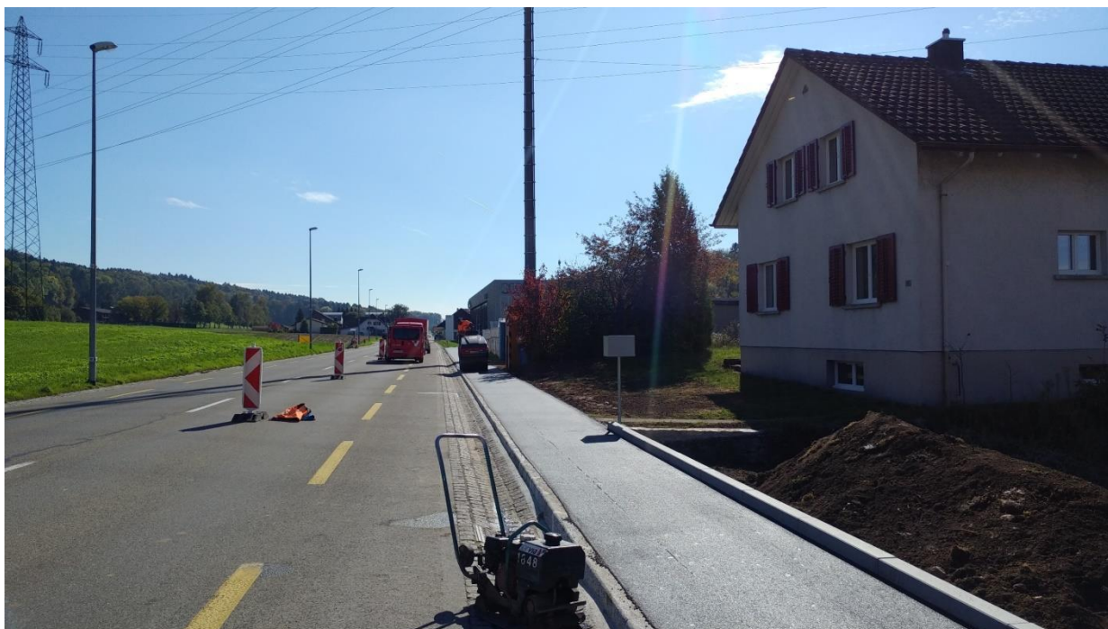
Neues Trottoir entlang der Oberrohrdorferstrasse (Strecke Dättwil-Oberrohrdorf)
