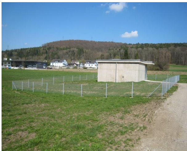
Umzäunte Grundwasserschutzzone I
