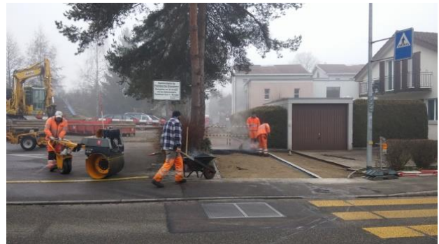
Belagseinbau beim Zugang Kindergarten Leematten
