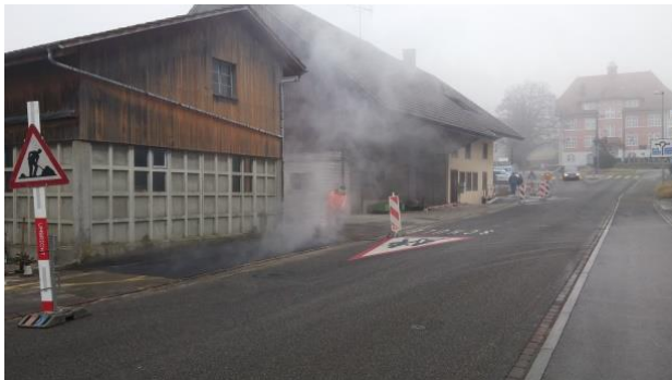
Belagseinbau bei der Gehwegverbreiterung Birmenstorferstrasse
