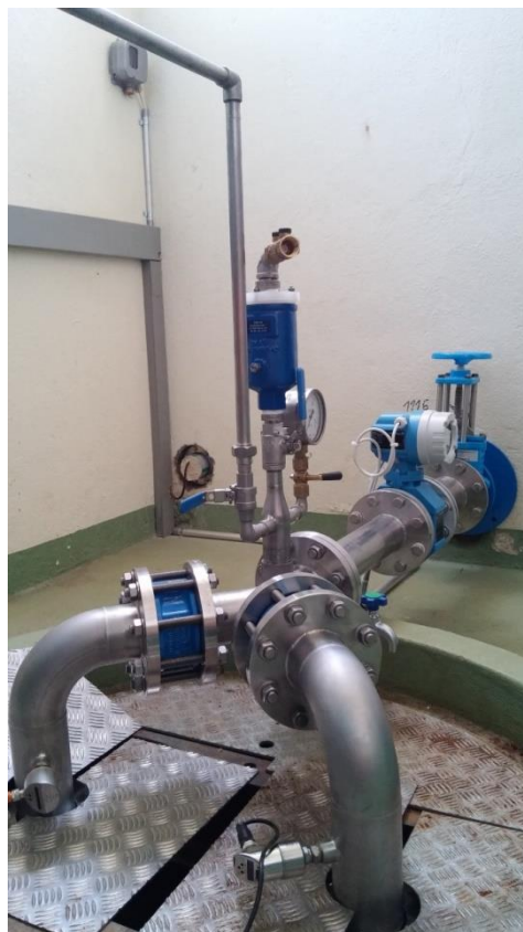
Umbau zu einem Anreicherungspumpwerk
