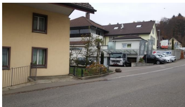
Anpassung der Gartenmauer bei der Liegenschaft Birmenstorferstr. 4
