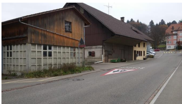
Gehwegverbindung Jura-/Badenerstrasse, Rückbau der Rabatte
