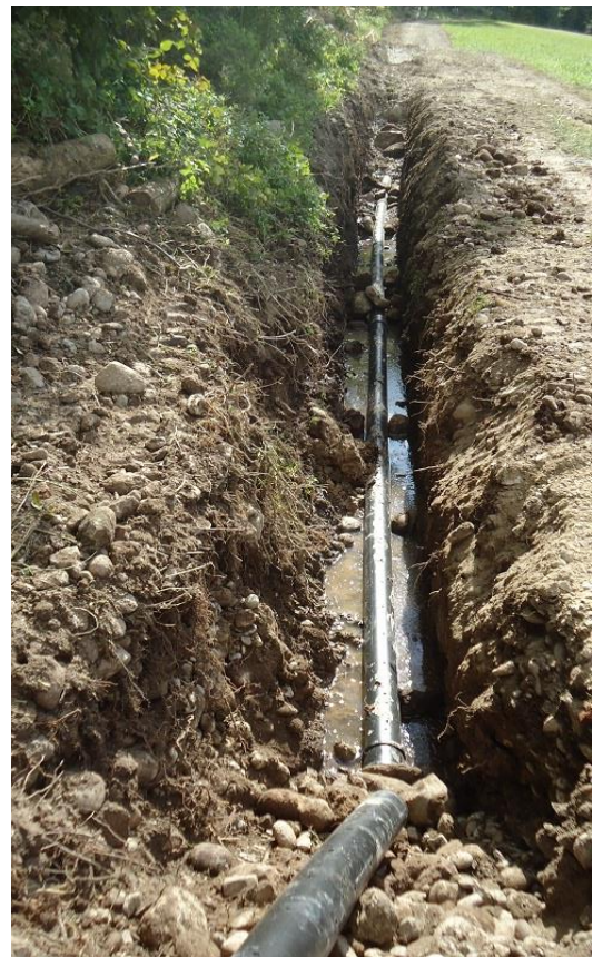
Neuer Entwässerungsgraben mit Sickerrohr
