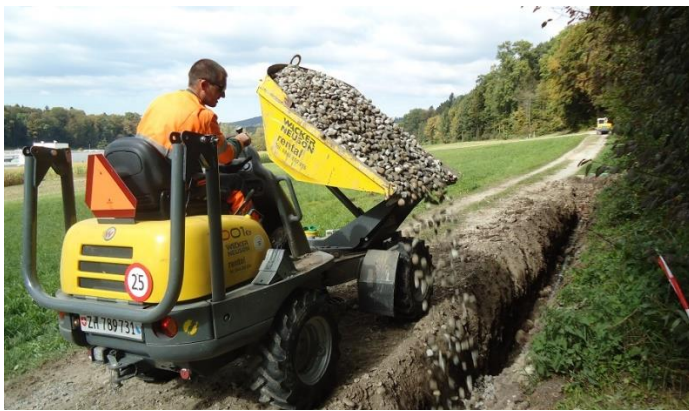
Einfüllen des Sickergerölls
