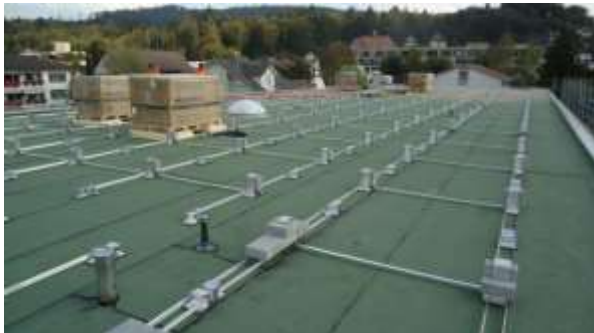
Flachdach mit Unterkonstruktion für die Photovoltaikanlage
