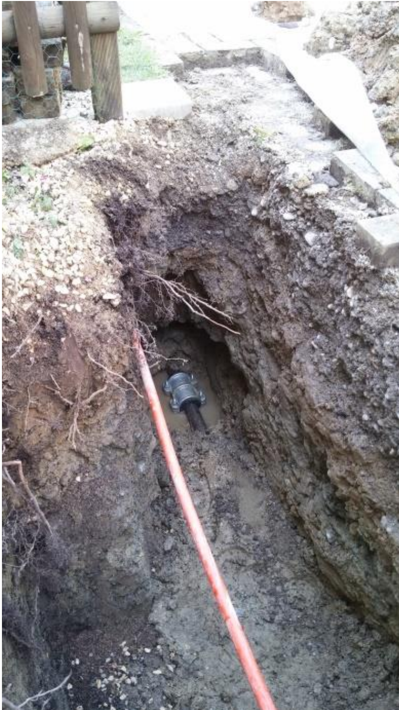
Abdichtung der Leckstelle einer Hauszuleitung mit einer Rohrschelle
