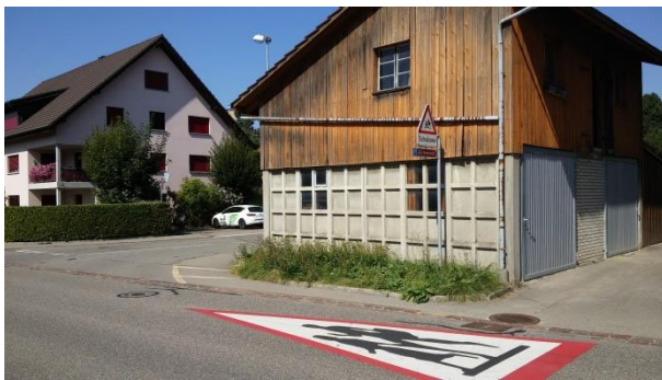
Rückbau der Rabatte neben der Einmündung Jurastrasse
