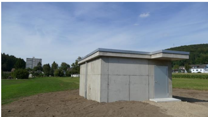
Neues Betriebsgebäude Grundwasserpumpwerk Moos
