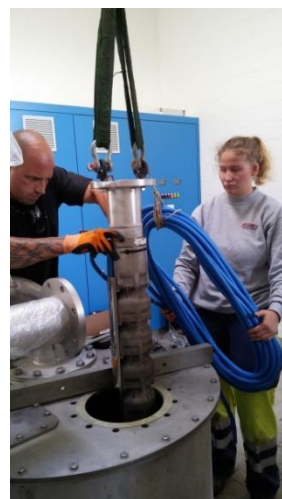
Einbau Unterwasserpumpe
