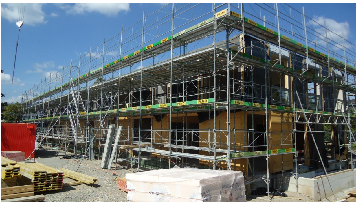
Der Neubau "Kolibri" ist aufgerichtet, Dach und Gebäudefronten sind erstellt.
