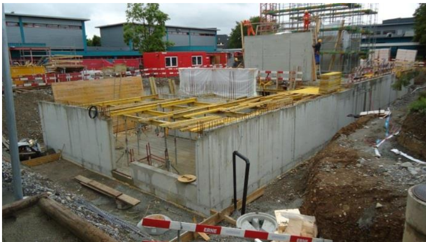
Der Neubau "Kolibri" nimmt Formen an
