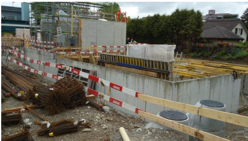
Betonierarbeiten im Unter- und Erdgeschoss
