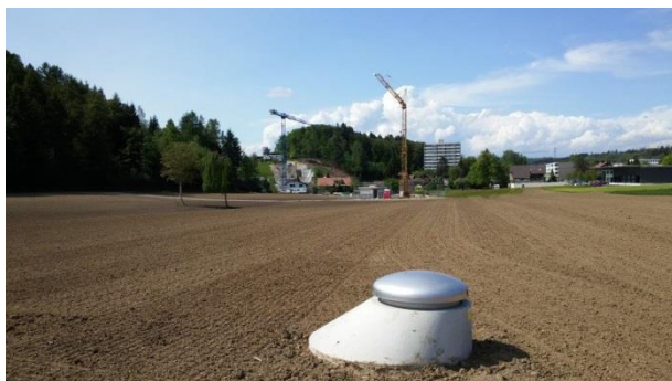
Schluckbrunnen (im Vordergrund) Im Hintergrund die Baustelle für das Pumpwerk
