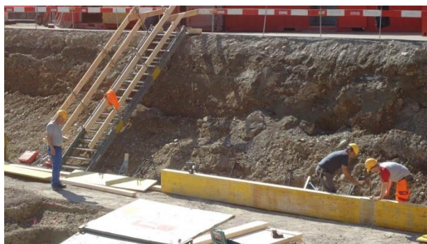
Bauarbeiter beim Abschalen der Bodenplatte
