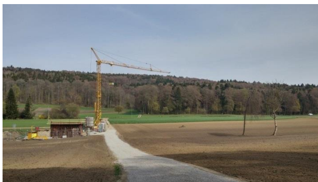
Betonierarbeiten für das neue Gebäude
