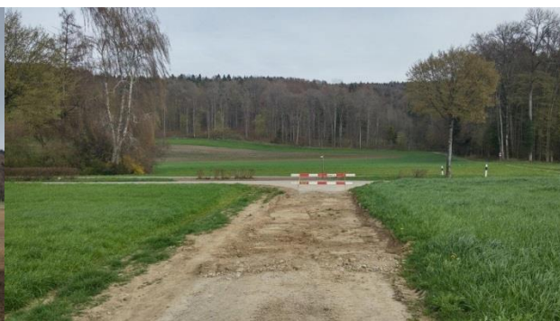
Rückbau des Feldweges
