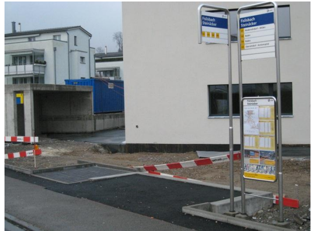
Vorbereitetes Fundament für Buswartehäuschen und Veloabstellplatz
