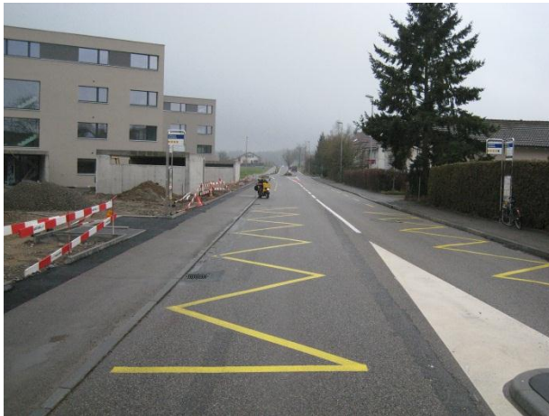
Mellingerstrasse (Fahrtrichtung Mellingen) Links: künftiger Standort Buswartehäuschen Rechts: Standort des geplanten Unterstands
