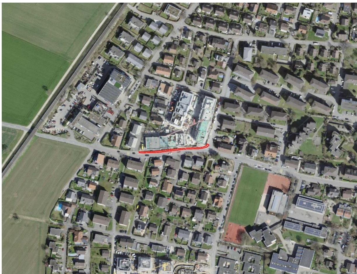
Neuer Gehweg entlang der Birmenstorferstrasse
