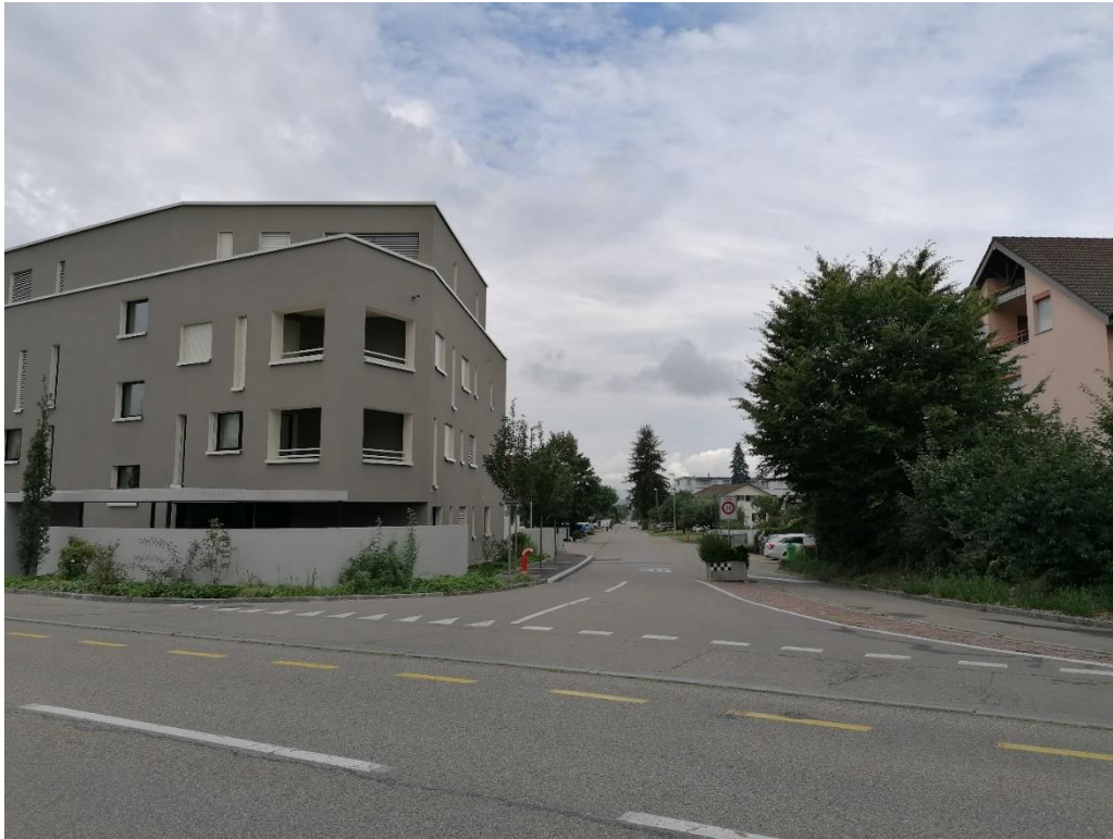
Steinackerstrasse – Ursprüngliche Einfahrt ab der Mellingerstrasse
