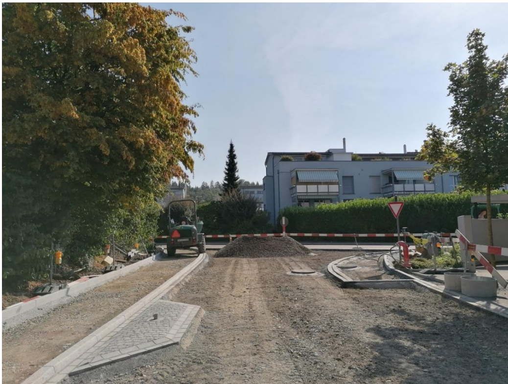
Steinackerstrasse – Neues Ein-/Ausgangtor in die Mellingerstrasse
